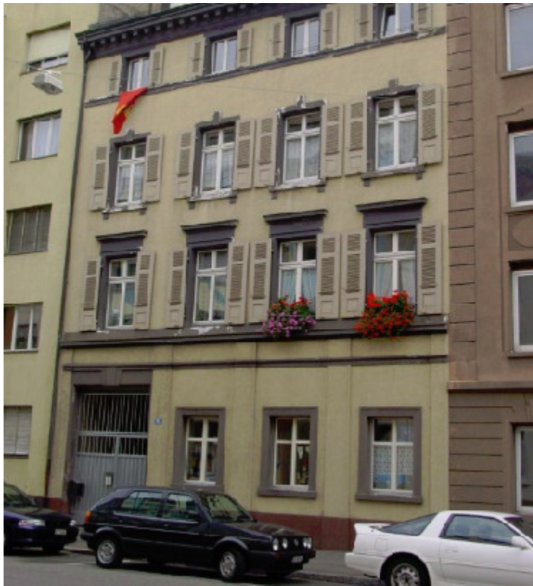
Haus zwischen verschiedenen Häusern, Klingentalstr. 82, 4057 Basel
